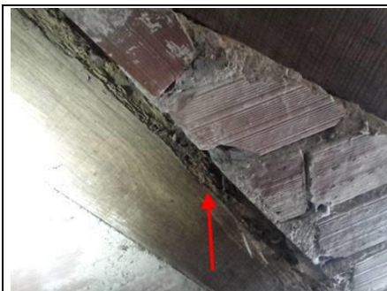
Photo n° PhTer001 Localisation : 1er étage - Grenier
