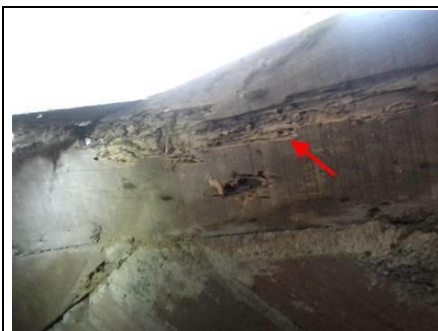
Photo n° PhTer001 Localisation : 1er étage - Grenier
