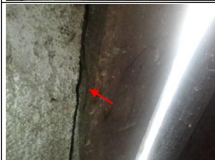
Photo n° PhTer001 Localisation : 1er étage - Grenier
