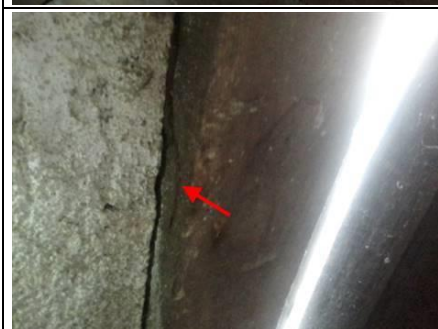
Photo n° PhTer002 Localisation : 1er étage - Grenier
