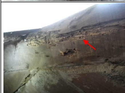
Photo n° PhTer002 Localisation : 1er étage - Grenier
