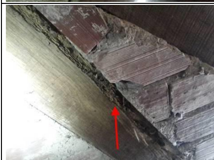
Photo n° PhTer002 Localisation : 1er étage - Grenier
