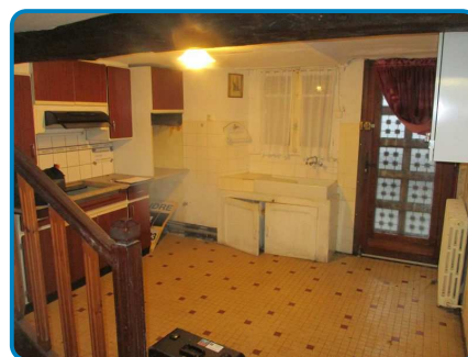
Rez de chaussée Cuisine
