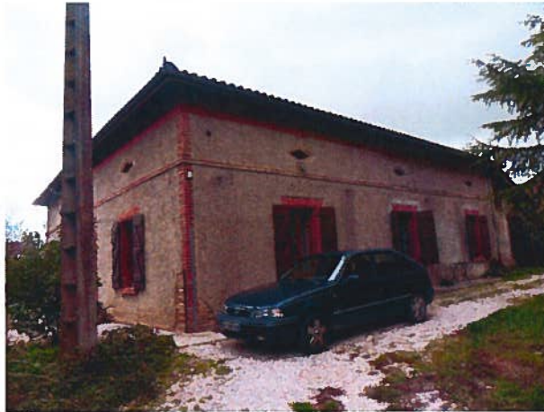
Façade sur cour
