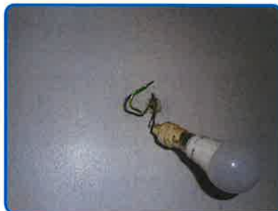
Anomalie B.8.3 b sur Install. n°3
