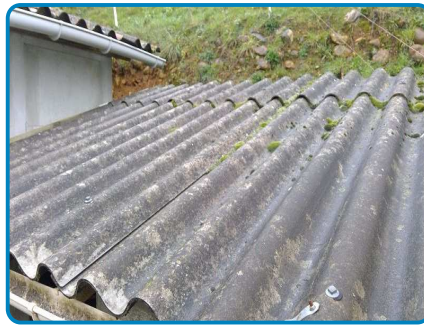
Toiture Plaques fibres ciment (dans Dépendance Rez de chaussée Garage)
