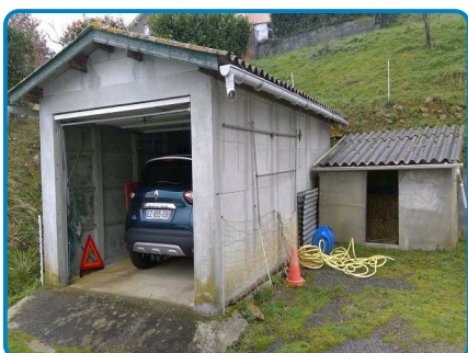
Dépendance Rez de chaussée Garage
