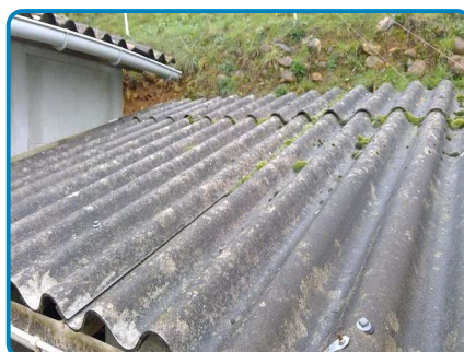
Toiture Plaques fibres ciment (dans Dépendance Rez de chaussée Garage)
