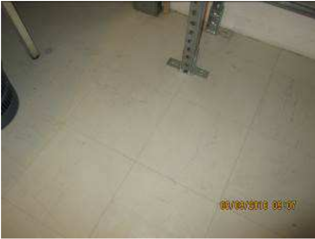
IV 1: Sous-sol / Energie - Dalle de sol - Photo n° 1
