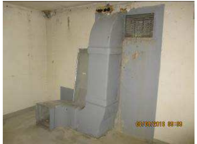
IV 4: Sous-sol / ACCUS 2 - Conduit - Photo n° 4
