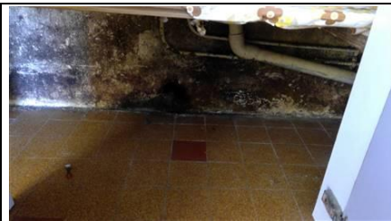
Photo n° PhTer001 Localisation : 1er étage - Cuisine Parasite : Moisissures Indices : Mur derrière placard de cuisine
