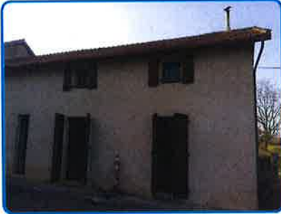
Maison principale Rez de chaussée Extérieur
