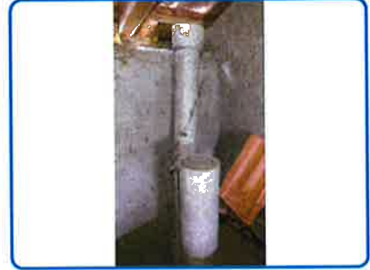
Conduit(s) de fluide Fibres ciment (dans Maison principale 1er étage Pièce 2)
