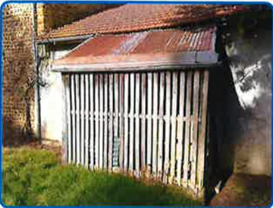
Dépendance 3 Rez de chaussée Extérieur
