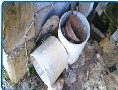
Conduit(s) de fluide Fibres ciment (dans Dépendance Rez de chaussée Grange)
