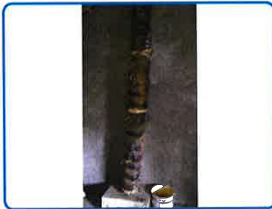
Conduit(s) de fluide Calorifuge / C (dans Maison principale 1er étage Pièce 3)
