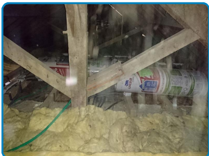
Maison principale 2ème étage Combles
