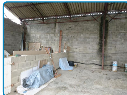
Autre Rez de chaussée Hangar
