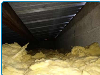
Maison principale 2ème étage Combles2
