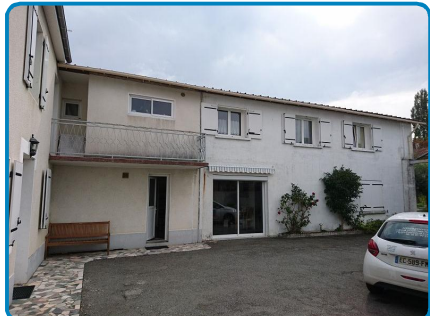
Maison principale Rez de chaussée Extérieur
