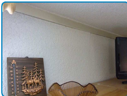
D.O. n° 2 sur Mur(coté balcon) Plaques fibres ciment
