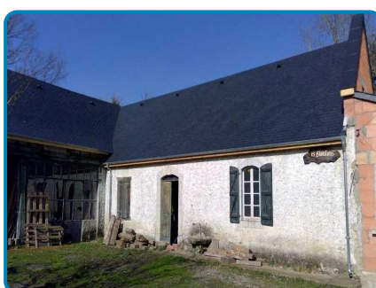
Maison principale Rez de chaussée Extérieur
