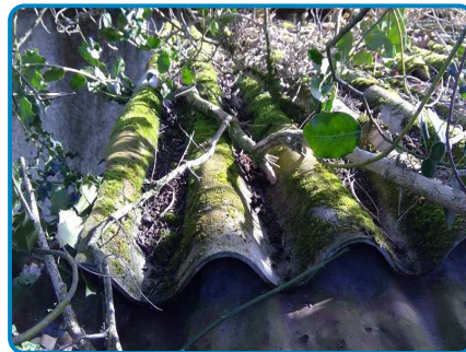
Toiture Plaques fibres ciment (dans Dépendance 3 Rez de chaussée Abri bois)
