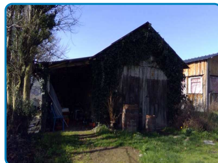
Dépendance 2 Rez de chaussée Extérieur
