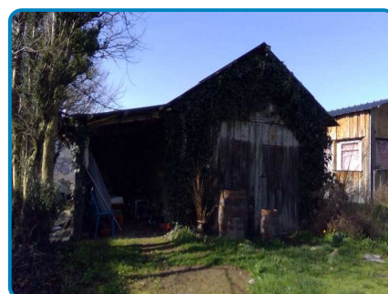
Dépendance 2 Rez de chaussée Extérieur
