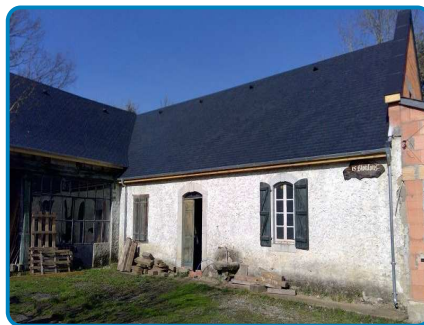
Maison principale Rez de chaussée Extérieur
