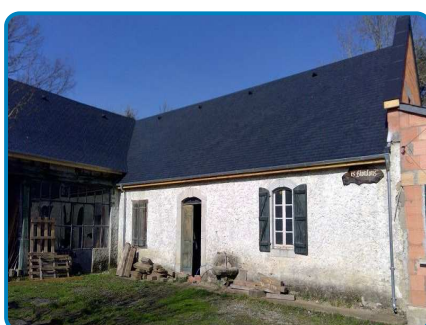
Maison principale Rez de chaussée Extérieur
