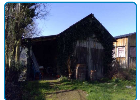
Dépendance 2 Rez de chaussée Extérieur
