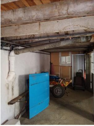
Sous sol. Pièce de rangement : Tuyau horizontal amiante-ciment. Produit fabriqué avant 1997. Produit protégé. Recommandation : évaluation périodique.
