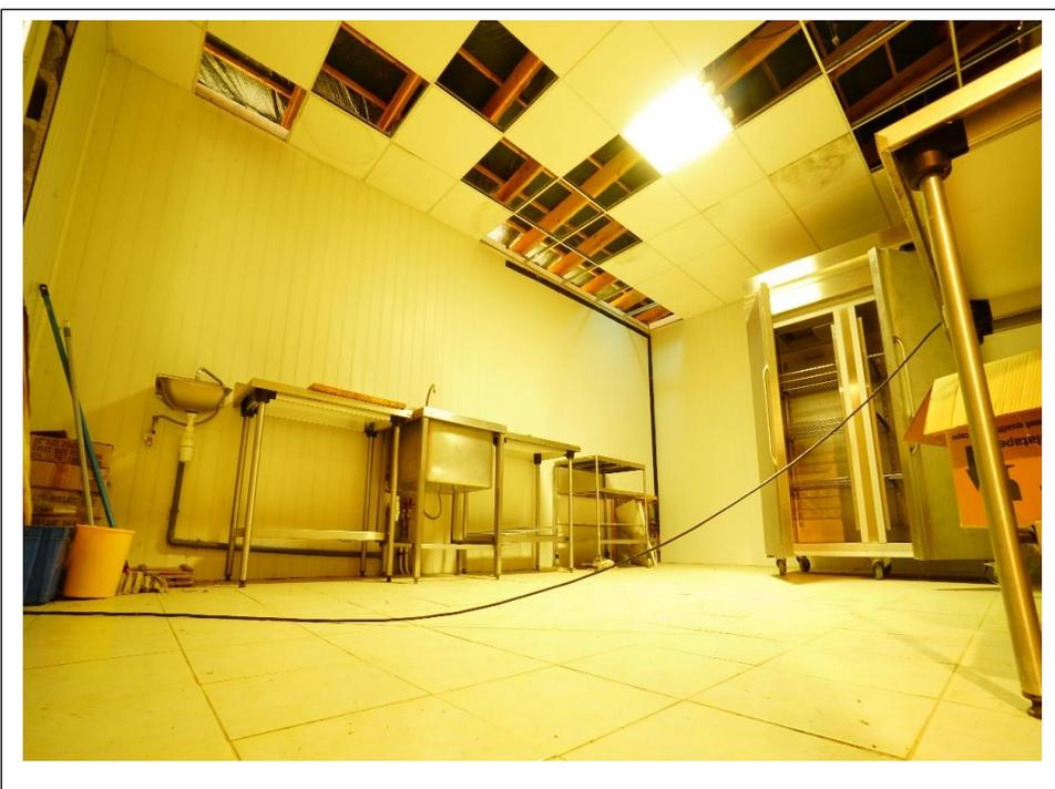
Par manque d'entretien, l'étanchéité du toit n'est plus assurée. Par conséquent, les plaques de faux plafond s'endommagent et tombent les unes après les autres. Il manque au moins 4 plaques de plafond en plus depuis notre dernière venue... Cela risque de continuer de s'aggraver
