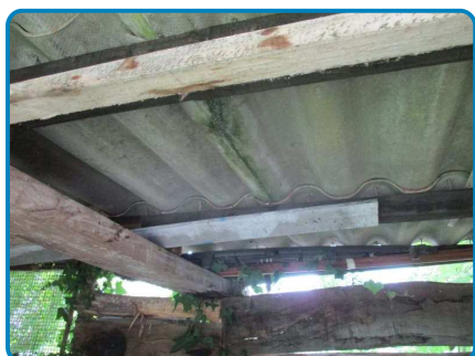
D.O. n° 4 sur Plafond Plaques fibres ciment
