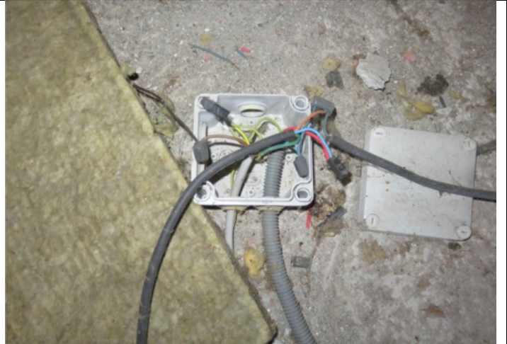
Absence de cache boîtier comble
