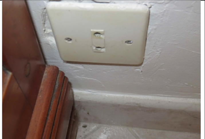
Prise simple sans broche de terre, sans puits , non obturée
