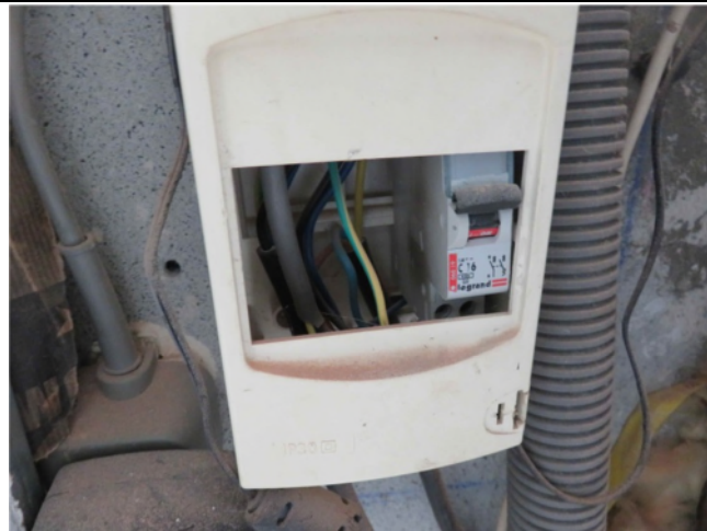
Absence de cache tableau compteur et AGCP
