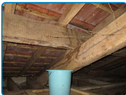
Maison principale 1er étage Combles n°1
