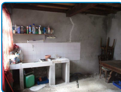
Maison principale Rez de chaussée Buanderie
