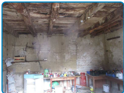
Maison principale Rez de chaussée Atelier
