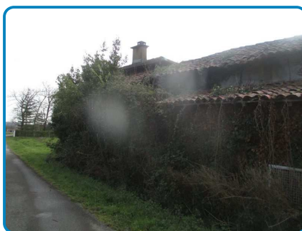
Maison principale Rez de chaussée Extérieur
