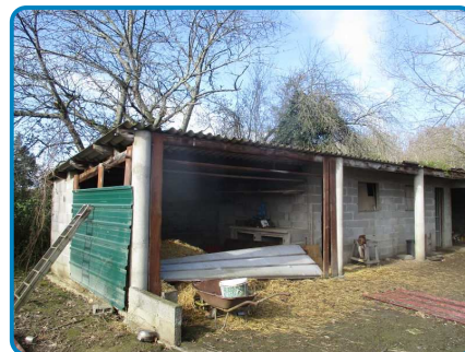
Dépendance Rez de chaussée Abri 2
