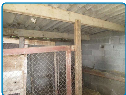
Dépendance Rez de chaussée Abri 2
