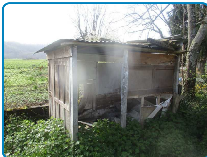
Dépendance Rez de chaussée Auvent
