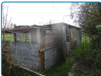
Dépendance Rez de chaussée Extérieur
