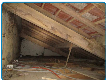
Maison principale 1er étage Combles n°1
