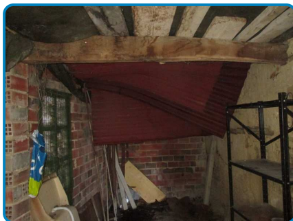
Maison principale Rez de chaussée Garage n°2
