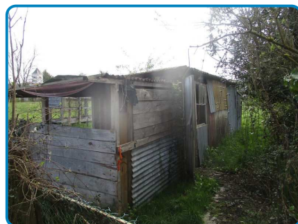
Dépendance Rez de chaussée Abri 1
