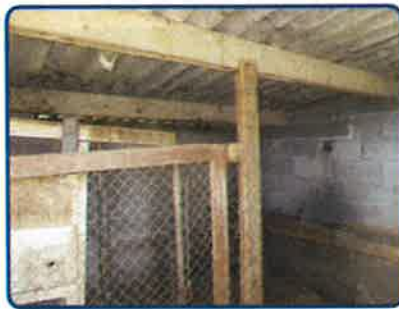
Dépendance Rez de chaussée Abri 2
