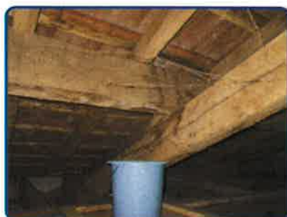
Maison principale 1er étage Combles n°1
