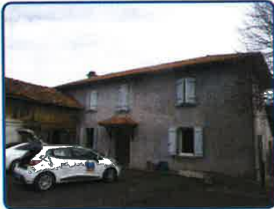
Maison principale Rez de chaussée Extérieur
