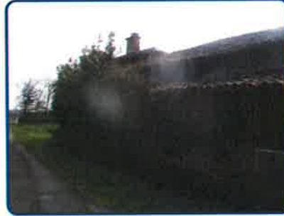
Maison principale Rez de chaussée Extérieur
