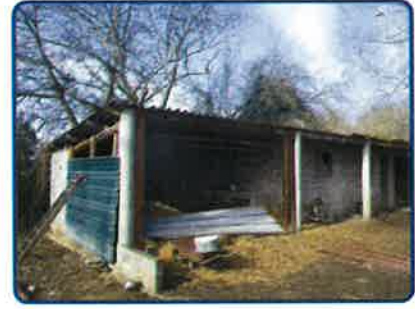
Dépendance Rez de chaussée Abri 2
