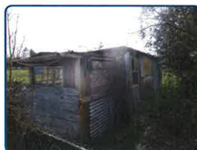
Dépendance Rez de chaussée Abri 1
