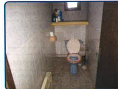
Maison principale Rez de chaussée WC
