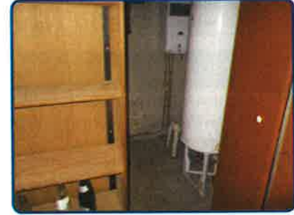
Maison principale Rez de chaussée Cellier
