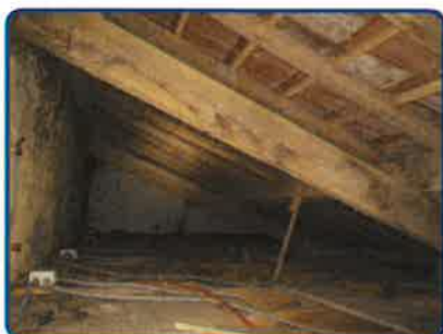
Maison principale 1er étage Combles n°1
