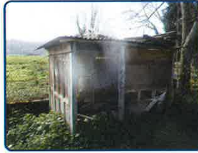
Dépendance Rez de chaussée Auvent
