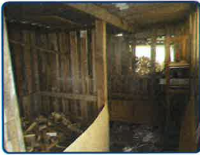
Dépendance Rez de chaussée Abri 1
