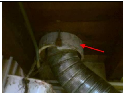
Photo n° PhA001 Localisation : Rez de jardin - Chaufferie Ouvrage : Conduits de fluides (air, eau, autres fluides) Partie d'ouvrage : Conduits Description : Conduits Localisation sur croquis : M004
