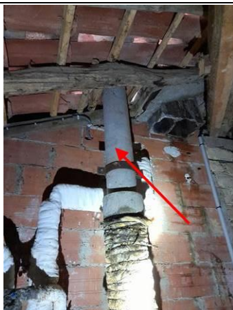
Photo n° PhA002 Localisation : Dépendance R+1 - Pièce 4 Ouvrage : Conduits de fluides (air, eau, autres fluides) Partie d'ouvrage : Conduits Description : Conduits Localisation sur croquis : M002
