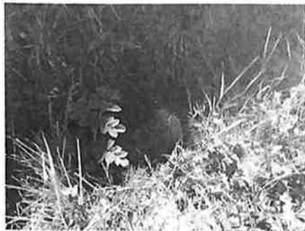
Rejet dans la fosse d'eaux ménagères non traitées
