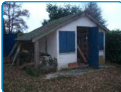
Dépendance Rez de chaussée Extérieur
