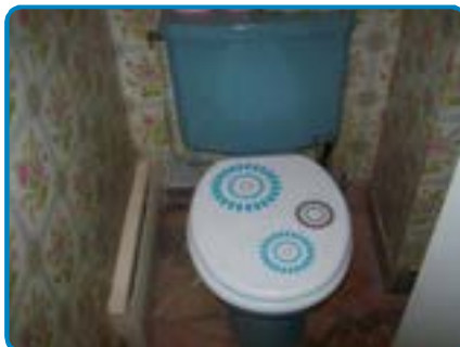
Maison 1er étage WC 1
