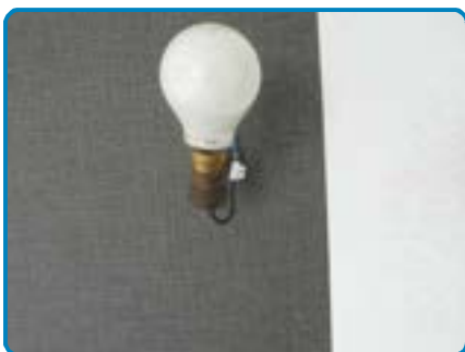
Anomalie B.7.3 e sur Install. n°1
