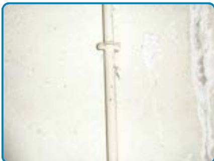
Anomalie B.3.3.7 a sur Install. n°1
