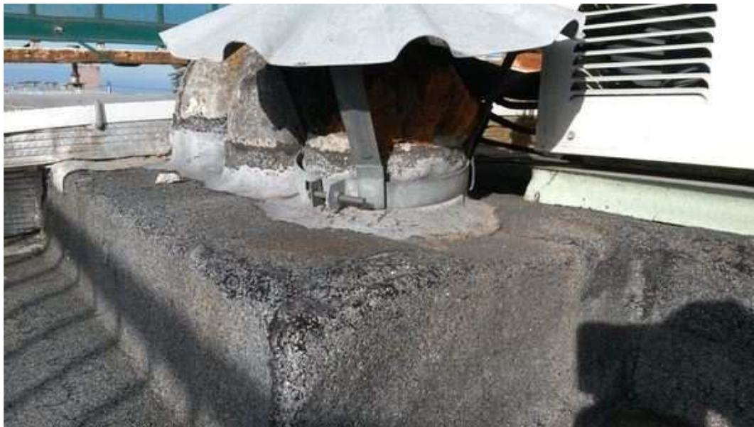
Terrasse 01 (Toiture) - Conduit de ventilation - Fibre ciment
