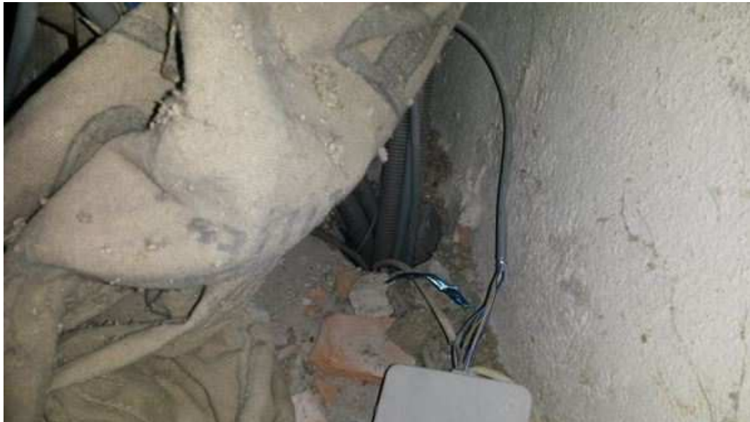
Plt 06 (3ème étage) - Sol - Conduit Fibre ciment
