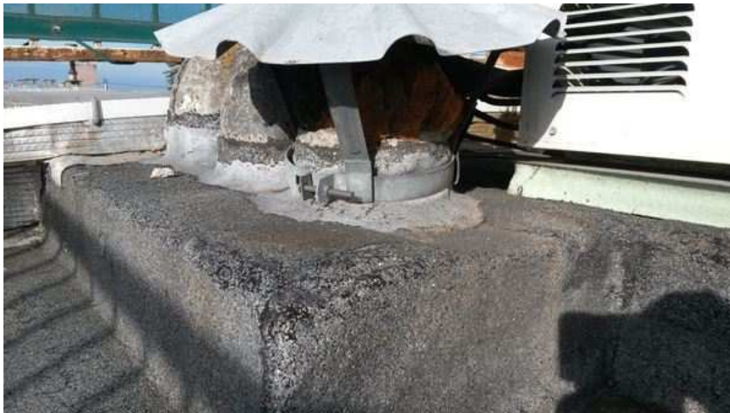
Terrasse 01 (Toiture) - Conduit de ventilation - Fibre ciment
