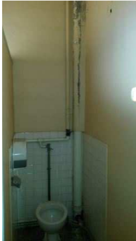
San 05 (3ème étage) - Conduit - Fibre ciment
