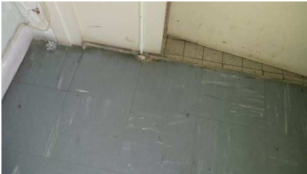
P3 - Circ 04 (3ème étage) - Sol - Dalles de sol grises
