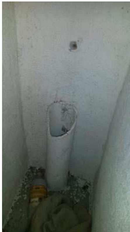
Pla 01 (1er étage) - Conduit de ventilation - Fibre ciment
