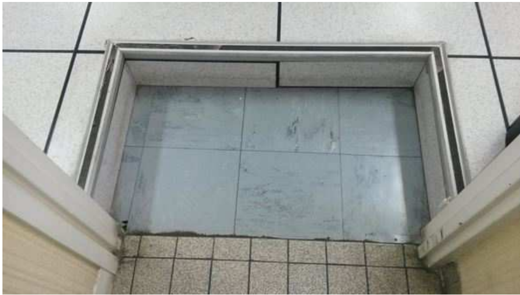
P2 - Bureau 02 (2ème étage) - Sol - Dalles de sol bleues
