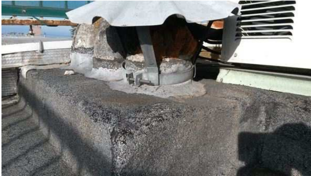
Terrasse 01 (Toiture) - Conduit de ventilation - Fibre ciment
