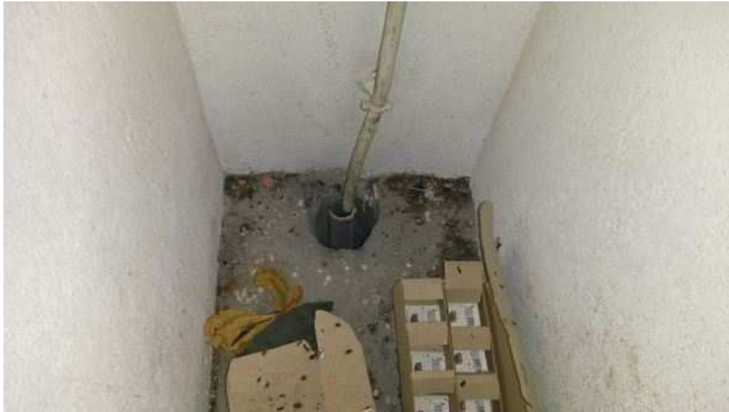
Plt 05 (3ème étage) - Sol - Conduit Fibre ciment
