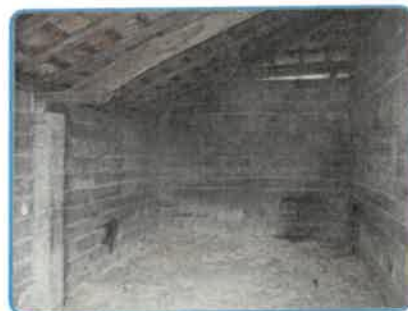
Maison principale Rez de chaussée Atelier2
