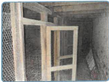
Maison principale Rez de chaussée Volière
