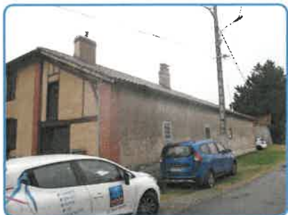
Maison principale Rez de chaussée Extérieur
