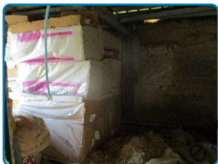
Rez de chaussée Chambre 1
