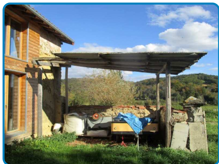
Rez de chaussée Auvent n°3
