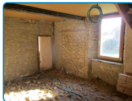
Rez de chaussée Chambre 2
