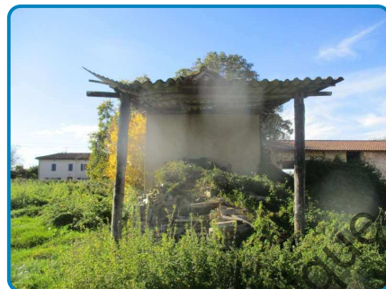
Rez de chaussée Auvent n°4
