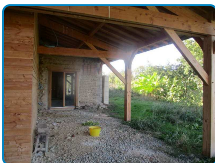
Rez de chaussée Auvent n°2
