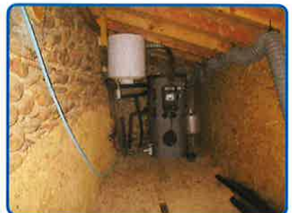
1er étage Local technique
