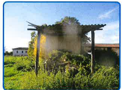
Rez de chaussée Auvent n°4
