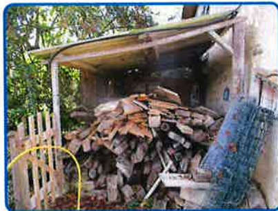
Rez de chaussée Auvent n°1
