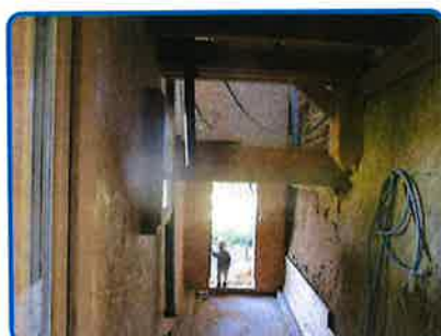
Rez de chaussée Couloir
