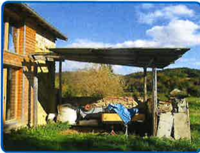
Rez de chaussée Auvent n°3
