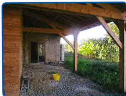
Rez de chaussée Auvent n°2
