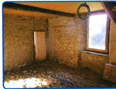
Rez de chaussée Chambre 2
