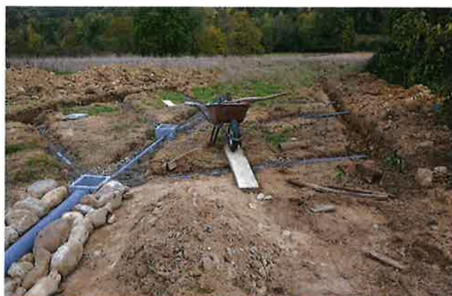
Dispositif non réglementaire avec les 2 tranchées (copeaux de bois en attente)
