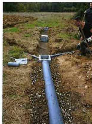
Arrivées des eaux usées brutes vers le dispositif non réglementaire
