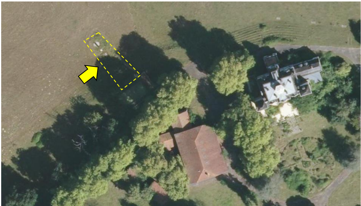
Localisation de la station d'épuration
