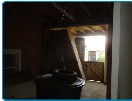
Dépendance Rez de chaussée Débarras n°1
