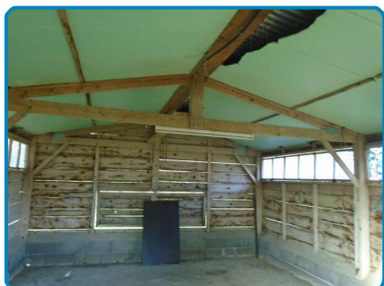
Dépendance Rez de chaussée Atelier n°3
