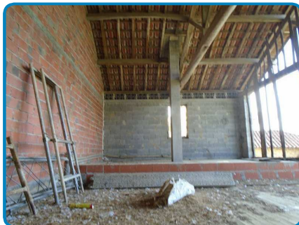
Dépendance 1er étage Grenier
