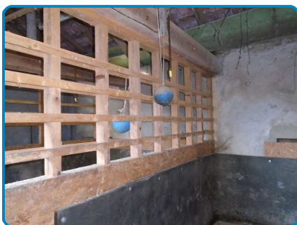
Dépendance Rez de chaussée Etable n°2
