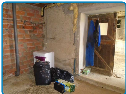
Maison principale Rez de chaussée Cellier
