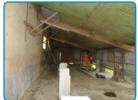
Dépendance Rez de chaussée Etable n°1
