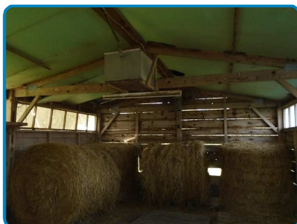
Dépendance Rez de chaussée Atelier n°4
