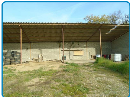
Dépendance Rez de chaussée Hangar
