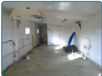
Dépendance Rez de chaussée Atelier n°1
