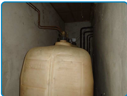
Dépendance Rez de chaussée Débarras n°2
