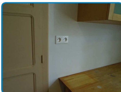
Anomalie B.3.3.6 a2 sur Install. n°1
