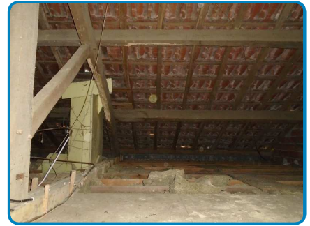
Maison principale 2ème étage Combles
