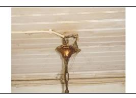
Photo Ele007 Libellé de l'anomalie : B3.3.6 a3 Au moins un circuit (n'alimentant pas des socles de prises de courant) n'est pas relié à la terre.
