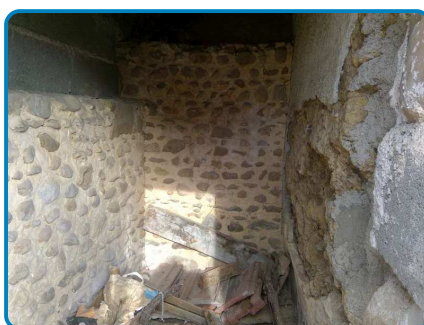
Maison principale Rez de chaussée Pièce 2
