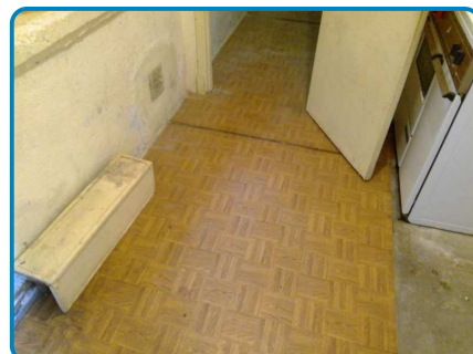
Maison principale Rez de chaussée Pièce
