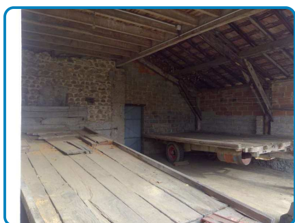
Maison principale Rez de chaussée Garage
