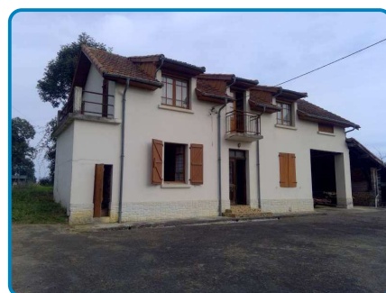
Maison principale Rez de chaussée Extérieur
