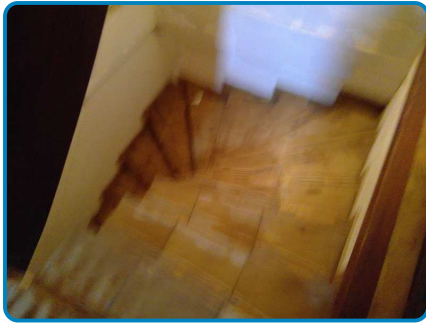
Maison principale Rez de chaussée Cage escalier vers R-1
