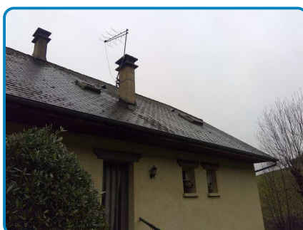
Maison principale Rez de chaussée Extérieur
