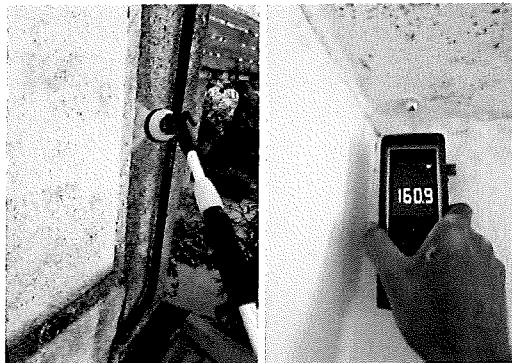
Aspersion jonction façade/mur béton – imprégnation des matériaux à l'aplomb
