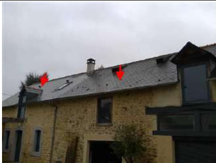
Photo n° PhA002 Localisation : Parties extérieures Ouvrage : Toitures Partie d'ouvrage : Ardoises (composites) Description : Ardoises (composites) Localisation sur croquis : ZPSO-002
