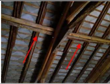
Photo n° PhA001 Localisation : Parties extérieures Ouvrage : Toitures Partie d'ouvrage : Ardoises (composites) Description : Ardoises (composites) Localisation sur croquis : ZPSO-001
