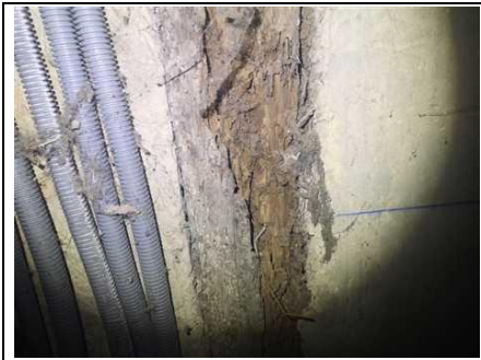
Photo n° PhTer001 Localisation : 1er étage - Grenier Ouvrage : Mur - enduit, colombages, briques et brut Parasite : Présence d'indices d'infestation de termites, Termites souterrains Indices : altérations dans le bois, bois d'apparence feuilleté, dégradation du bois, présence de cordonnets
