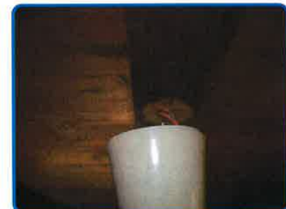
Anomalie B.3.3.6 a3 sur Install. n°1
