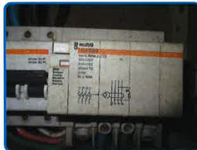
Anomalie B.2.3.1 i sur Install. n°1 (PROTEC.DIFF.) Anomalie B.2.3.1 h sur Install. n°1 (PROTEC.DIFF.) Anomalie B.1.3 b sur Install. n°1 (AGCP)
