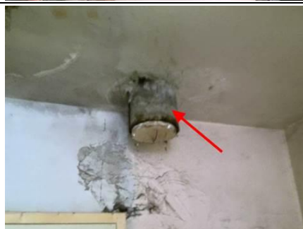
Photo n° PhA002 Localisation : Rez de chaussée - Atelier Ouvrage : 6 - Conduits et accessoires intérieurs - Conduits de fluides (air, eau, vapeur, fumée, échappement, autres fluides) Partie d'ouvrage : Conduit en fibres-ciment Description : Conduit en fibres-ciment
