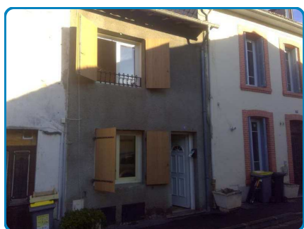
Maison principale Rez de chaussée Extérieur
