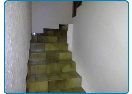
Maison principale Rez de chaussée Cage escalier
