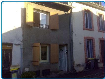
Maison principale Rez de chaussée Extérieur
