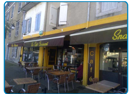
Maison principale Rez de chaussée local commercial
