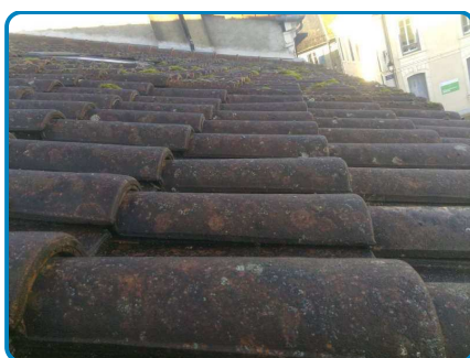
Maison principale Rez de chaussée Extérieur
