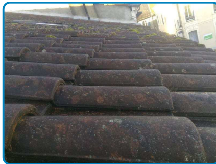
Maison principale Rez de chaussée Extérieur
