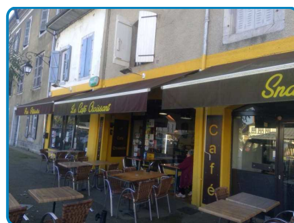
Maison principale Rez de chaussée local commercial
