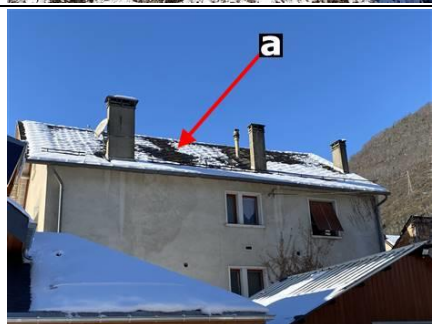
Photo n° PhA012 Localisation : Toiture - Couverture Ouvrage : Toitures Partie d'ouvrage : Ardoises (fibres-ciment) Description : Ardoises (fibres-ciment) Localisation sur croquis : ZPSO-012
