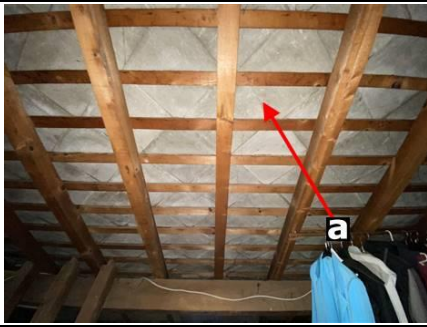
Photo n° PhA012 Localisation : Toiture - Couverture Ouvrage : Toitures Partie d'ouvrage : Ardoises (fibres-ciment) Description : Ardoises (fibres-ciment) Localisation sur croquis : ZPSO-012
