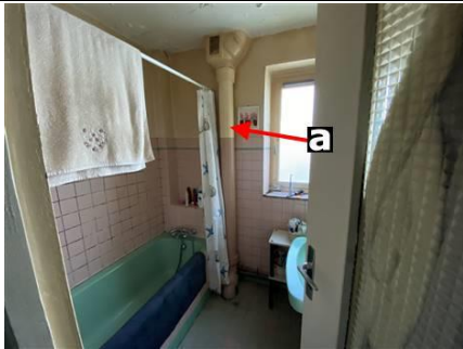
Photo n° PhA006 Localisation : 1er étage - Salle de bain 1 Ouvrage : Conduits de fluides (air, eau, autres fluides) Partie d'ouvrage : Conduits Description : Conduits Localisation sur croquis : ZPSO-006
