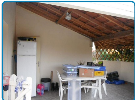
Maison principale Rez de chaussée Auvent n°1
