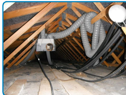
Maison principale 1er étage Combles
