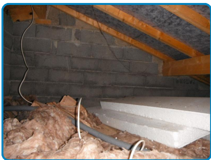
Maison principale 1er étage Combles
