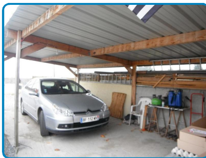
Dépendance Rez de chaussée Auvent n°2
