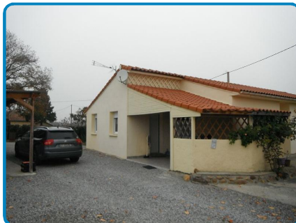
Maison principale Rez de chaussée Extérieur
