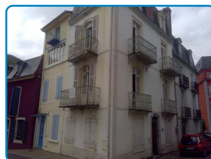
Maison principale Rez de chaussée Extérieur
