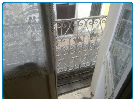
Maison principale 1er étage Balcon 2
