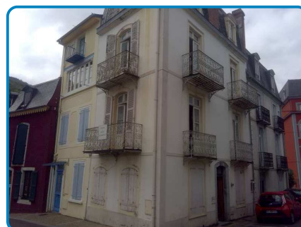
Maison principale Rez de chaussée Extérieur
