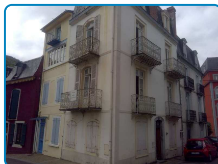
Maison principale Rez de chaussée Extérieur
