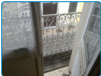
Maison principale 1er étage Balcon 2
