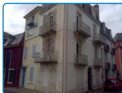
Maison principale Rez de chaussée Extérieur
