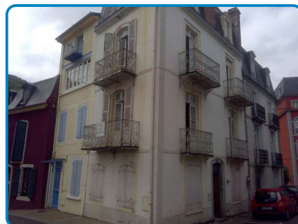
Maison principale Rez de chaussée Extérieur
