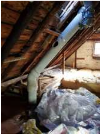
Photo n° A1 Localisation : Comble Ouvrage : Canalisation fibrociment amiante M001 Localisation sur croquis : Grenier M001
