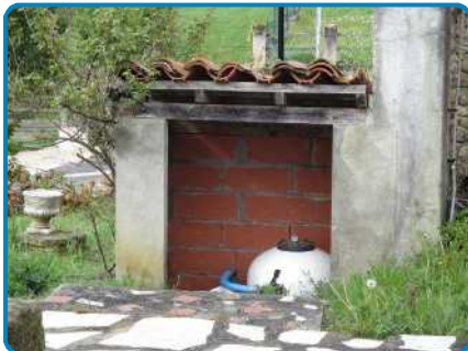
Dépendance Rez de chaussée Abri piscine
