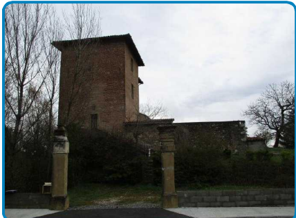
Maison principale Rez de chaussée Extérieur
