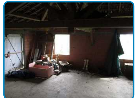
Dépendance Rez de chaussée Garage
