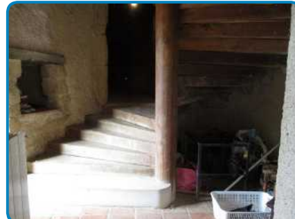
Maison principale Rez de chaussée Cage escalier
