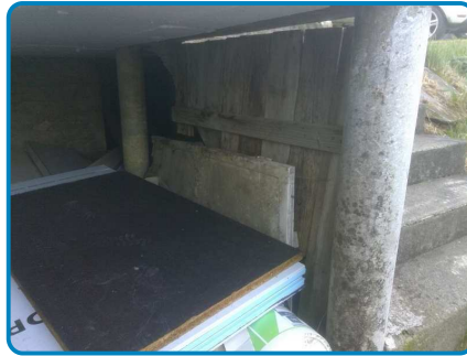
Poteaux Fibres ciment (dans Maison principale Rez de chaussée Extérieur)
