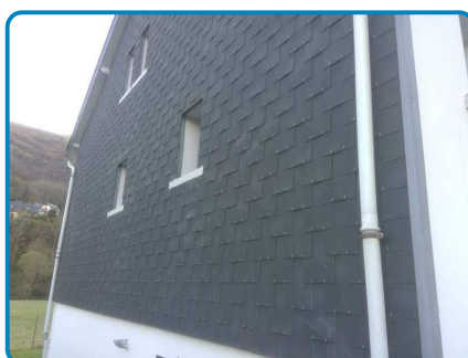
Maison principale Rez de chaussée Extérieur Bardage Ardoises fibre-ciment (dans Maison principale Rez de chaussée Extérieur)
