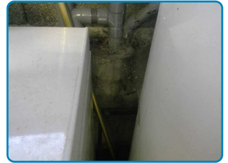
Conduit(s) de fluide Fibres ciment (dans Maison principale 1 2 Sous sol Cave)
