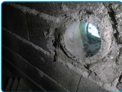
Conduit(s) de fluide Fibres ciment (dans Maison principale 1 2 Sous sol Cave 3)
