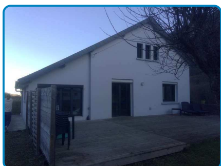
Maison principale Rez de chaussée Extérieur
