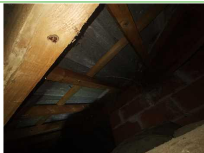
Photo n° PhA001 Localisation : 1er étage - Combles Ouvrage : 1 - Couvertures, Toitures, Terrasses et étanchéités - Plaques ondulées et planes Partie d'ouvrage : Plaques en fibres-ciment (y compris plaques « sous tuiles ») Description : Plaques ondulées fibro-ciment Localisation sur croquis : M001
