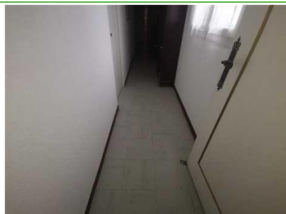
Photo n° PhA002 Localisation : Rez de chaussée - couloir; Rez de chaussée - Chambre 1; Rez de chaussée - Chambre 2; Rez de chaussée - Chambre 3 Ouvrage : 5 - Planchers et planchers techniques - Revêtements de sols Partie d'ouvrage : Dalle de sol Description : Dalle de sol Localisation sur croquis : M002
