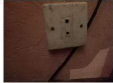
Photo PHEle008 Libellé de l'anomalie : B3.3.6 a1 Au moins un socle de prise de courant ne comporte pas de broche de terre.
