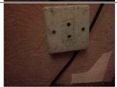
Photo PHEle009 Libellé de l'anomalie : B3,3.6 a2 Au moins un socle de prise de courant comporte une broche de terre non reliée à la terre.
