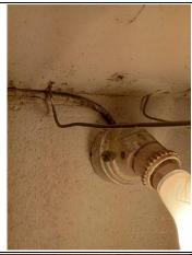
Photo PHEle007 Libellé de l'anomalie : B8.3 d L'installation comporte au moins un conducteur actif dont le diamètre est inférieur à 12/10 mm (1,13 mm²).
