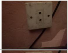
Photo PHEle011 Libellé de l'information complémentaire : B11 b2 Au moins un socle de prise de courant n'est pas de type à obturateur
