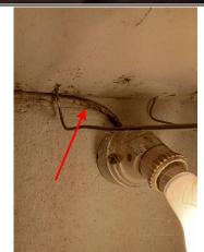
Photo PHEle013 Libellé de l'anomalie : B3.3.7 a Au moins un conduit métallique en montage apparent ou encastré, comportant des conducteurs, n'est pas relié à la terre
