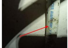
Photo n° PHGaz002 14 : la date limite d'utilisation du tuyau d'alimentation n'est pas lisible ou est dépassée. (Cuisine)
