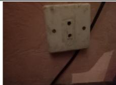
Photo PHEle012 Libellé de l'information complémentaire : B11 c2 Au moins un socle de prise de courant ne possède pas un puits de 15 mm.
