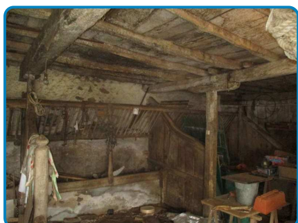
Dépendances Rez de chaussée Etable
