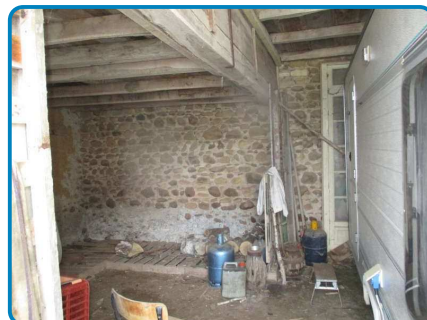
Dépendances Rez de chaussée Abri bois
