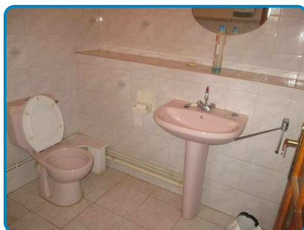
Maison principale 1er étage WC
