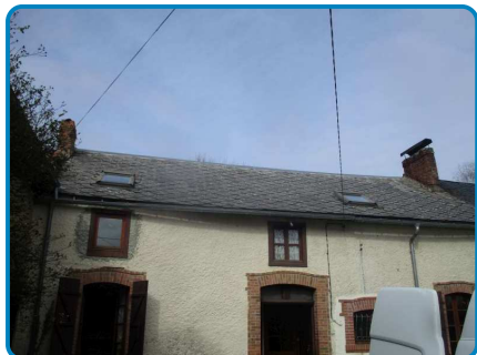
D.O. n° 1 sur Toiture sud Ouest Ardoises fibre-ciment
