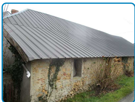
Maison principale Rez de chaussée Extérieur
