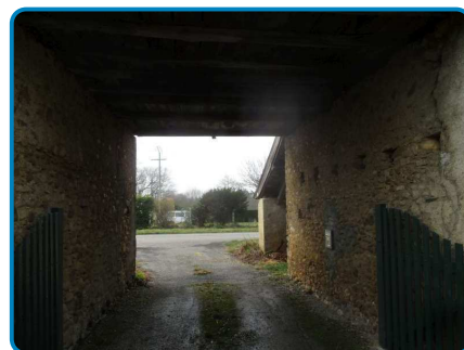
Dépendances Rez de chaussée Porche
