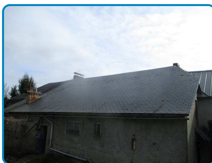
Maison principale Rez de chaussée Extérieur
