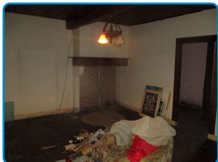
Maison principale Rez de chaussée Séjour
