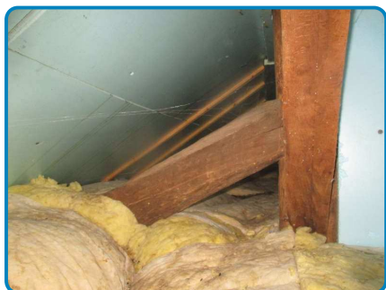
Maison principale 2ème étage Combles
