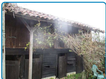
Dépendances Rez de chaussée Porcherie
