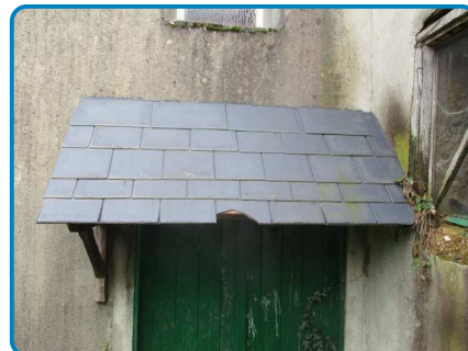
D.O. n° 3 sur Toiture nord Ouest Ardoises fibre-ciment D.O. n° 4 sur Toiture marquise Ardoises fibre-ciment
