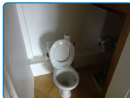
Maison principale Rez de chaussée WC
