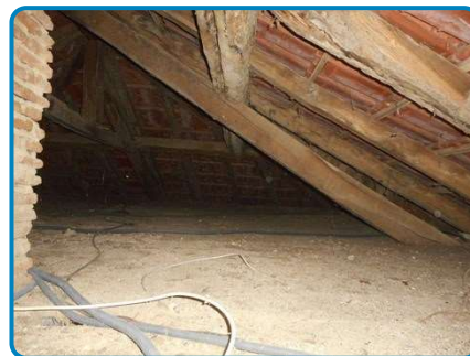
2ème étage Combles Est
