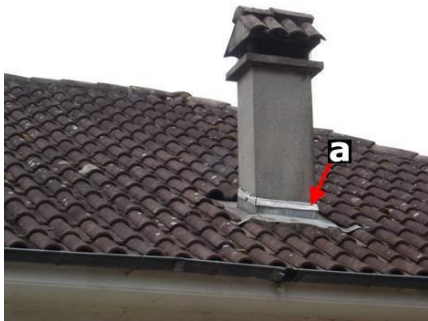
Photo n° PhA006 Localisation : Dépendance - Garage Ouvrage : Toitures Partie d'ouvrage : Accessoires de couvertures (composites) Description : Accessoires de couvertures (composites) Localisation sur croquis : ZPSO-006
