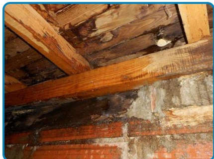
Plafond Bois (dans Rez de chaussée Chai)
