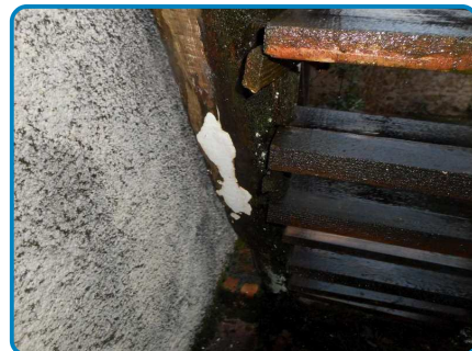
Garde Corps / Rampe / main courante Bois (dans 1er étage Auvent)
