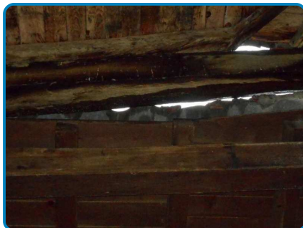
Plafond Plaques fibres ciment (dans Rez de chaussée Auvent)
