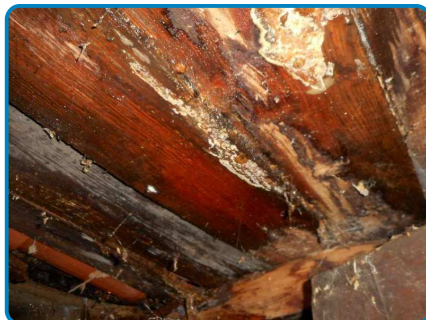
Plafond Voliges bois (dans Rez de chaussée Poulailier)
