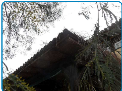
Toiture Plaques fibres ciment (dans Rez de chaussée Extérieur)
