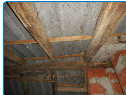
Plafond Plaques fibres ciment (dans 2ème étage Comble salon)
