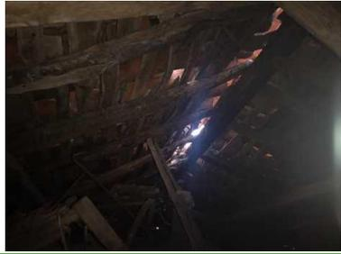
Photo n° dégradations importantes sur les charpentes et les couvertures
